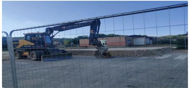
Les travaux de l'école ont commencé par l'installation du chantier, comprenant l'arrachage des arbres et décaissement. Création de la plate forme.
